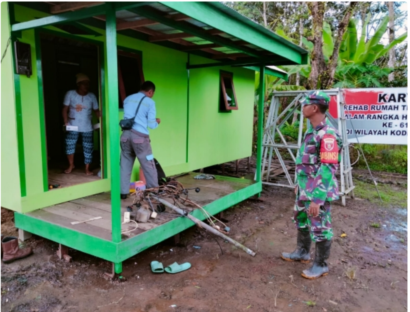
Melengkapi Renovasi RTLH Babinsa 1005-03/Rantau Badauh Monitoring Instalasi Listrik Dipasang
