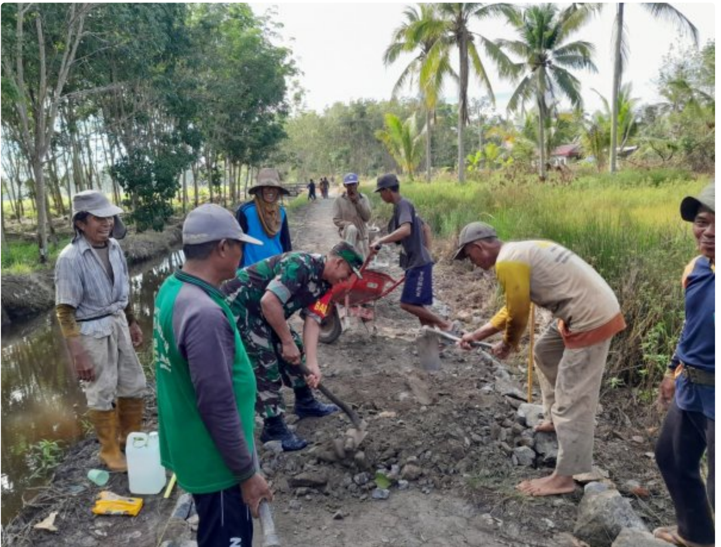
Bersama warga Binaan Babinsa Koramil 1005-10/Tamban Perbaiki Jalan Menuju Perkebunan
