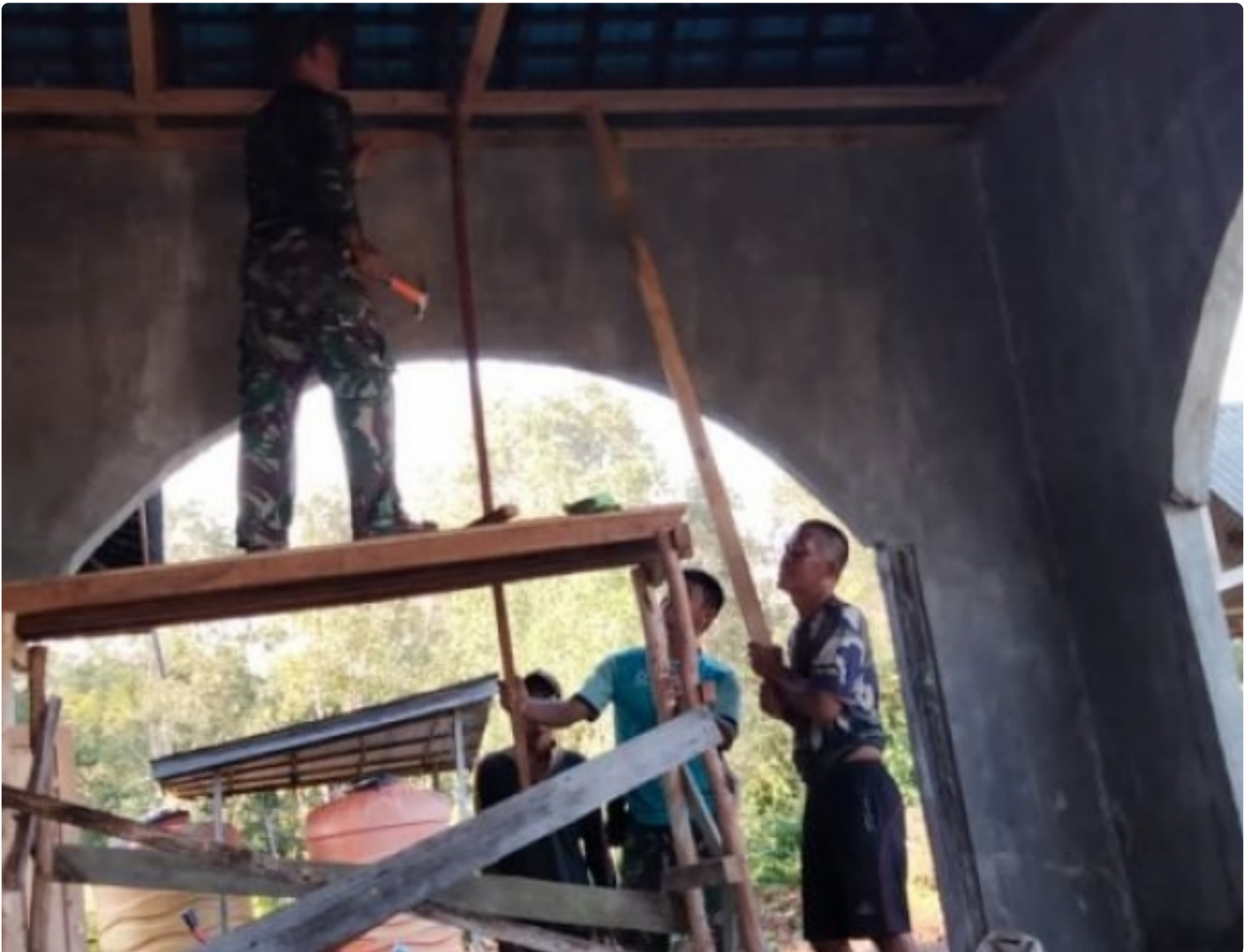
Anggota Satgas TMMD Gotong Royong Rehab Mesjid Jami
